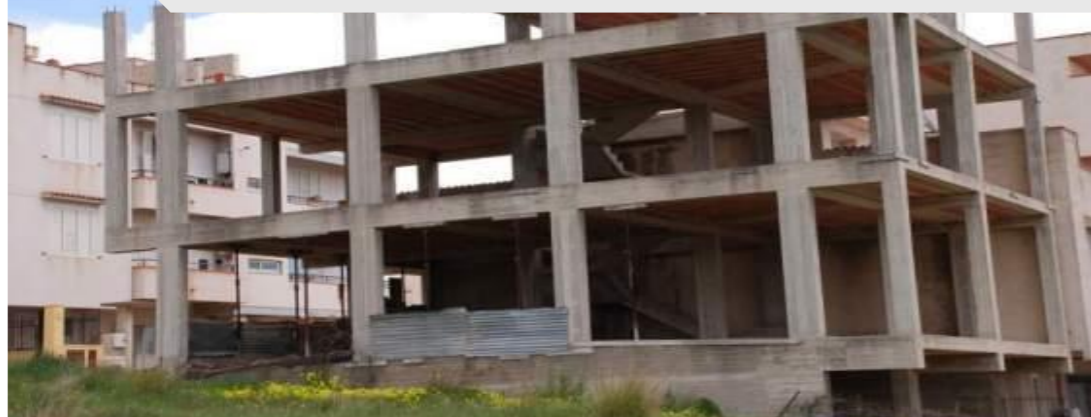
Fabbricati in costruzione
